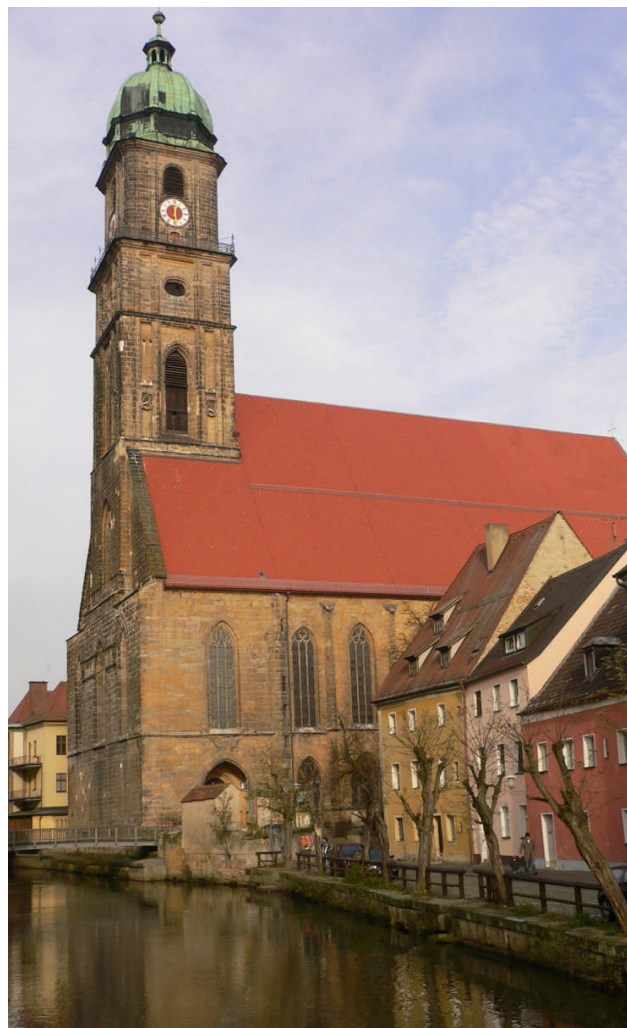
Der Bund fördert die Turm-Sanierung der Basilika St. Martin in Amberg mit einer halben Million Euro.
